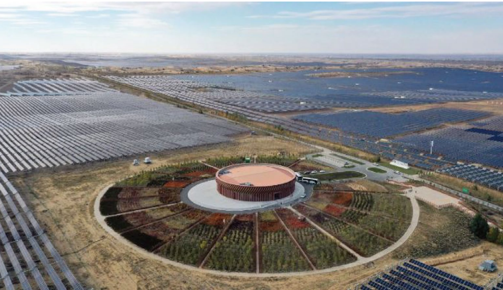
圖說：蒙西庫布其沙漠 200 萬千瓦光伏治沙專案施工現場
